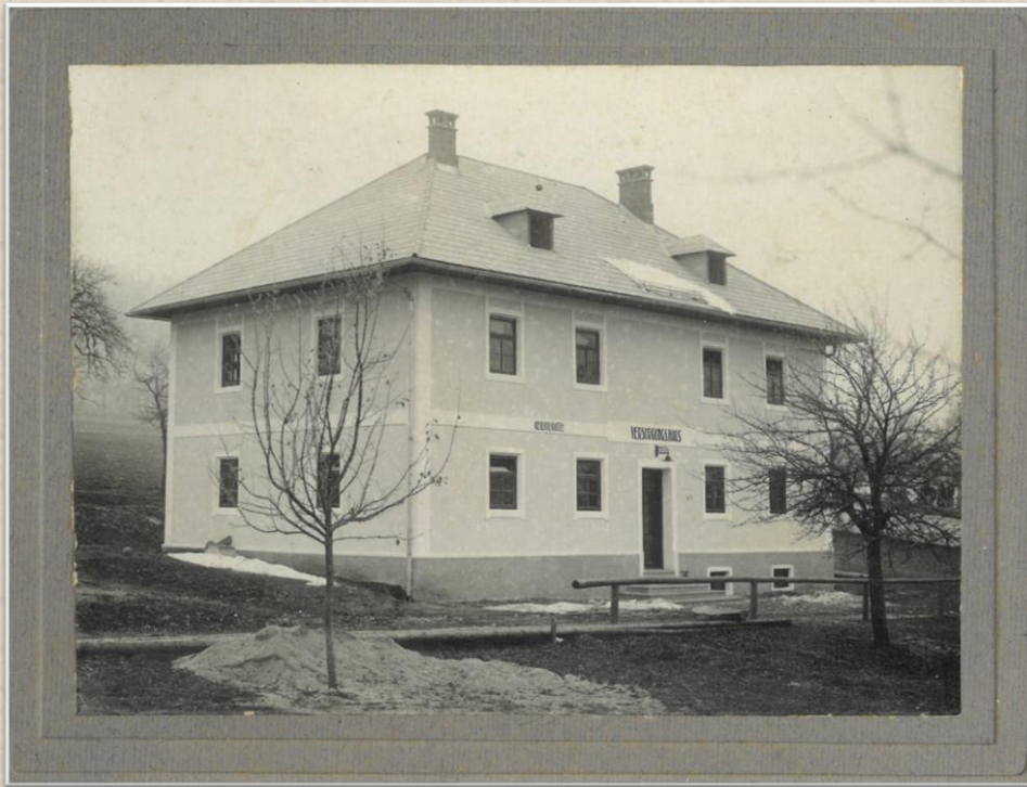
Gemeindeamt St. Konrad, erbaut 1927; Damals noch Versorgungshaus genannt.
